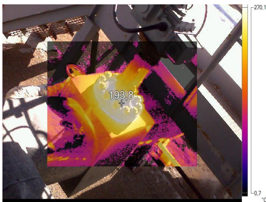
Рисунок 4 - Замер температуры на выходной гребенке
