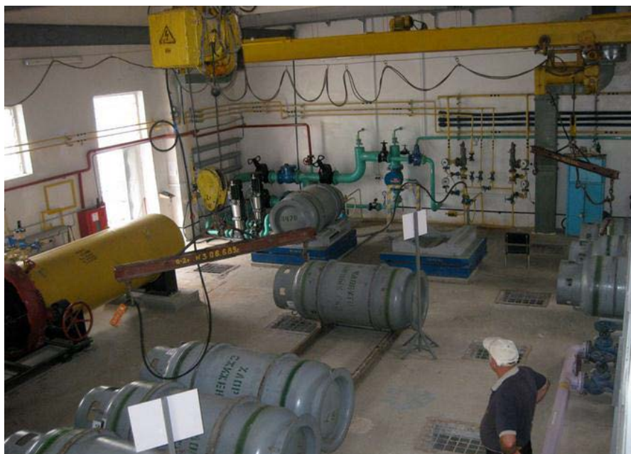
2 – сурет - Хлор қоймасы бар хлоратор
