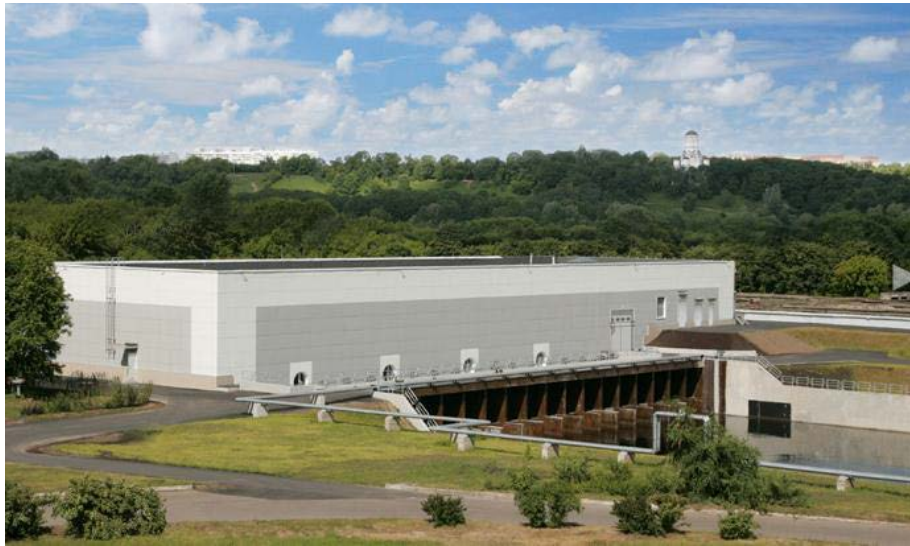
3 – сурет - Өнімділігі тәулігіне 3 млн. текше метр тазарту құрылыстарын ультракүлгін дезинфекциялау блогы.
