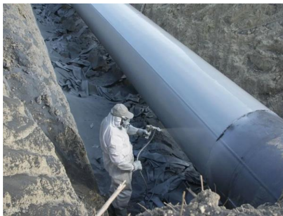
Рисунок 4. Нанесение полимерного покрытия
