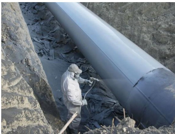
Рисунок 4. Нанесение полимерного покрытия
