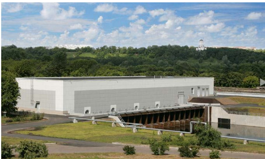
3 – сурет - Өнімділігі тәулігіне 3 млн. текше метр тазарту құрылыстарын ультракүлгін дезинфекциялау блогы. А-архитектуралық-жобалық шешім; Б-салынған блок.
